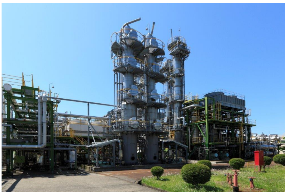
越路原プラント(新潟県長岡市)
